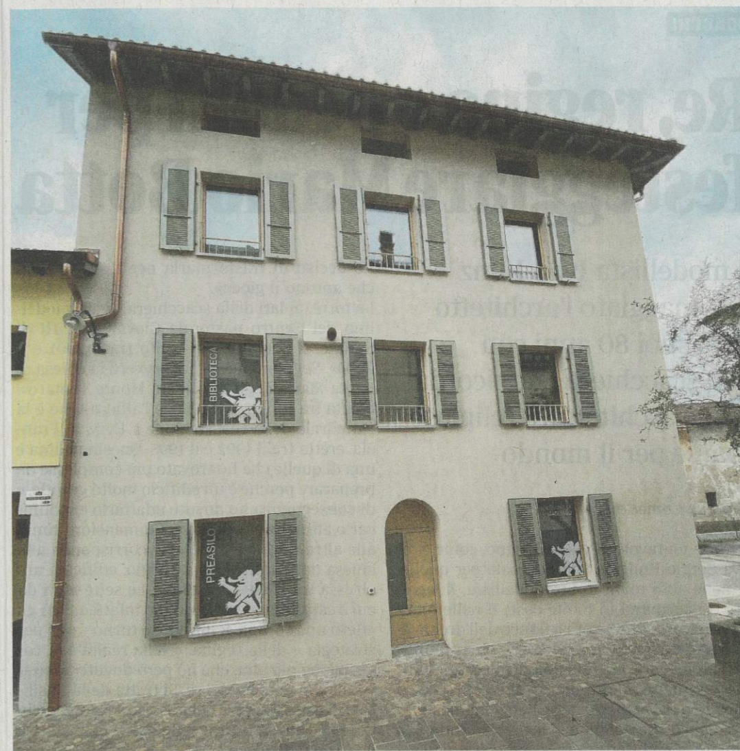
I lavori sono entrati nella fase conclusiva
