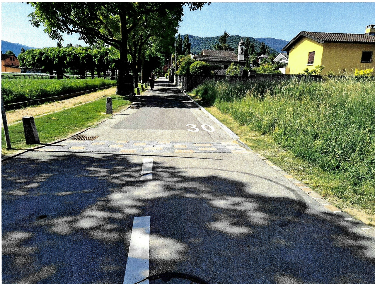
Figura 7 – Vista generale su via Vedeggi
